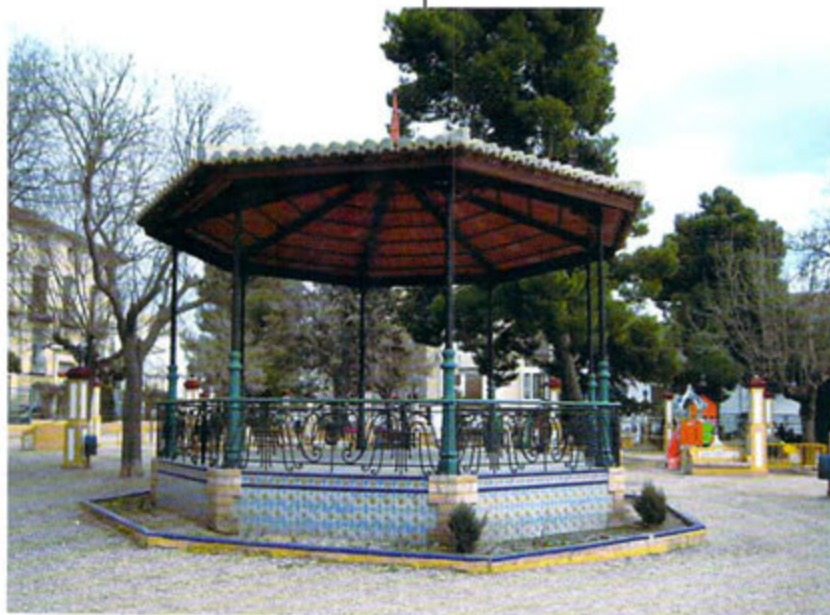
Pérgola de La Glorieta actualmente
